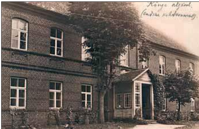
Rõugõ kihlkunnakooli hoonõ 1927. aastagal – parhillaki Rõugõ põhikuul.
